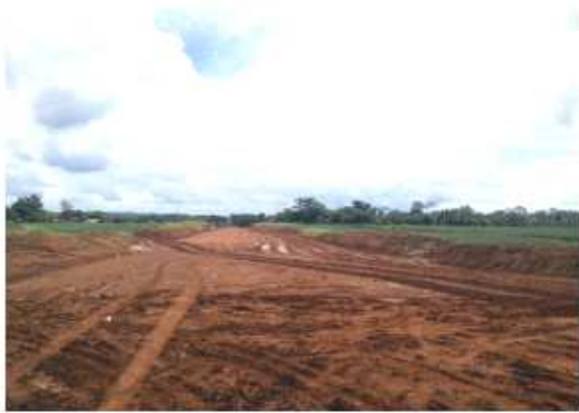
Vista de la construcción de terraplenes en el sector del km 3-065 a 3-200.
