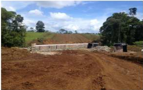
Estación 13+160 Construcción de la alcantarilla de cuadro.
