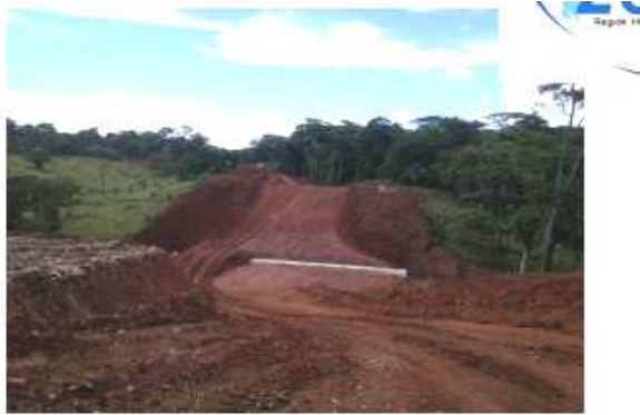
Vista panorámica del colocación de la alcantarilla en la estación 7-030.
