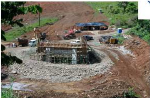
Estación 10+600 Vista General Puente sobre el Río Cuarto.
