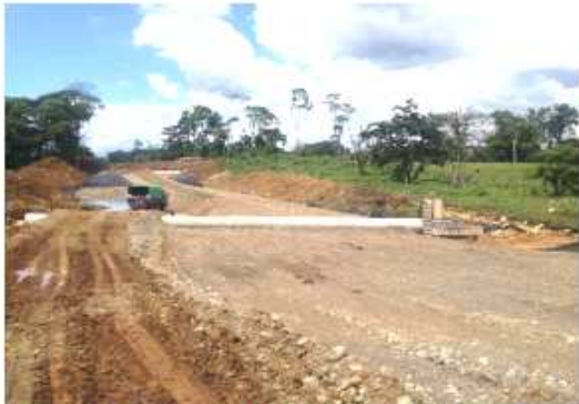
Vista proceso de la subexcavación para mejoramiento entre las estaciones 3-540 y 3-680.
