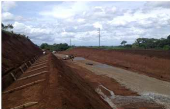
Estación 25+650 Construcción de la sub-rasante y construcción de cauce
