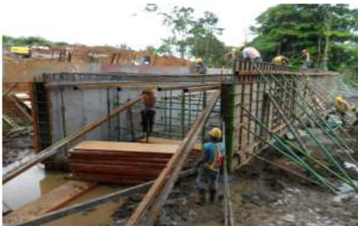
Estación 15+731 Construcción de la alcantarilla de cuadro.
