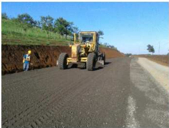
Estación 25+200 Colocación de préstamo capa Estructural.
