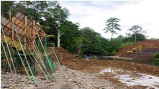
Estación 10+600 Proceso de construcción del Puente sobre el Río Cuarto.
