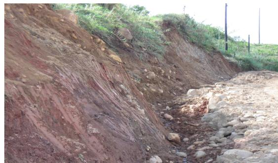
Imágenes de los trabajos realizados para reestablecer el paso tras el deslizamiento el cual produjo el colapso de aproximadamente de tres cuartas partes (3/4) del camino los cuales consistieron en la ampliación de la vía en aproximadamente 5m de ancho y así garantizar el libre tránsito.
