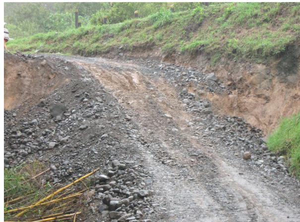
Fotografías del sector (1) donde se da uno de los deslizamientos el cual se encuentra activo cuya proporción y mecanismo de falla hacen necesaria una inversión difícilmente estimable sin contar con un estudio geológico y geotécnico detallado del sitio que brinde además opciones posibles de estabilización que ya de antemano indico serán de un costo muy elevado.
