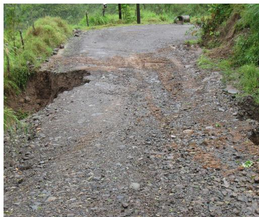
Fotografías del sector (2) donde se dan otros dos de los deslizamientos quedando prácticamente intransitable el camino.
