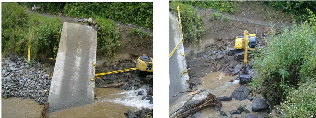
Losa del puente que colapso sobre el Río La Vieja, la cual debe ser removida. (4)
