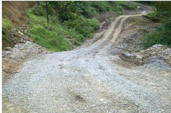
Fotografías del sector (1) donde constantemente se le realizan trabajos para mantenerlo transitable debido a que por encontrarse activo genera que el material sea prácticamente absorbido, se trabaja canalizando las aguas para de alguna manera evitar que el deslizamiento genere más daños.
