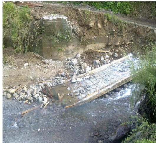
Se derriba la losa del puente que colapso sobre el Río La Vieja lo que implica que se puede seguir avanzando con los trabajos de campo con respecto al puente Bailey.
