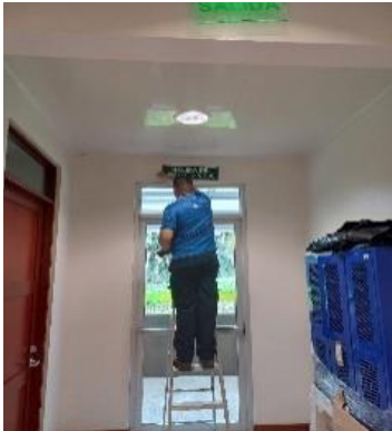
Colocación de rotulación
