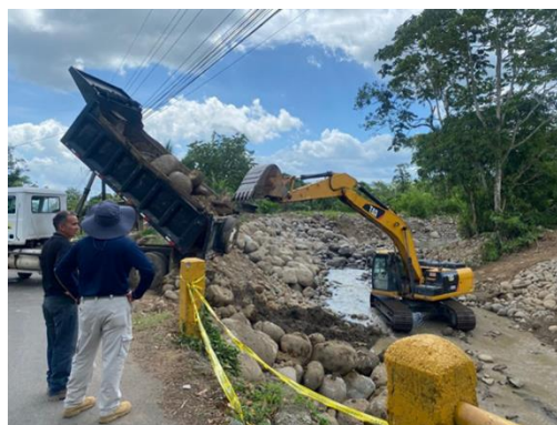
Construcción de enrocados, Los Lotes de Aguas Zarcas Fuente: Comisión Municipal de Emergencias
