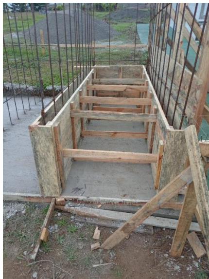
Construcción de nichos
