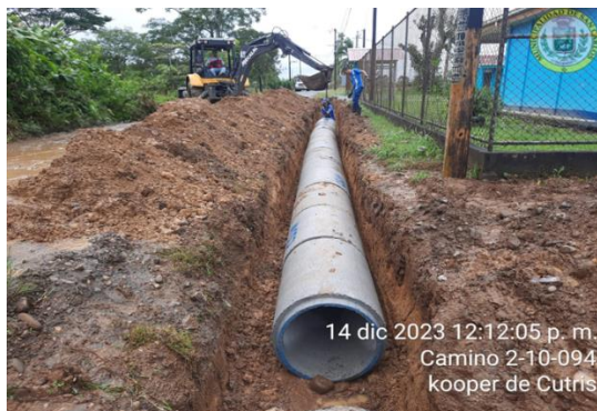
Colocación de alcantarillado Kopper de Cutris
