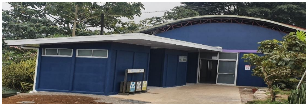
Construcción de baterías en Desarrollo Social
