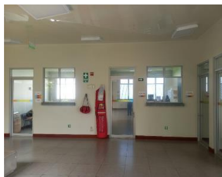
Revisión de equipo de emergencia
