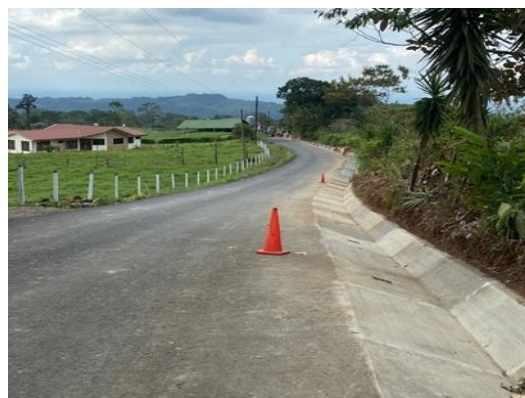
Cunetas para mitigar la erosión en margen del cauce, río Aguas Zarcas
