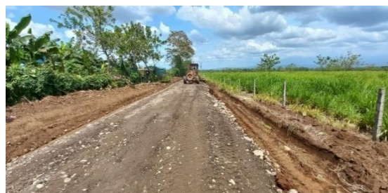
Evacuación Pluvial, Montelimar, Monterrey
