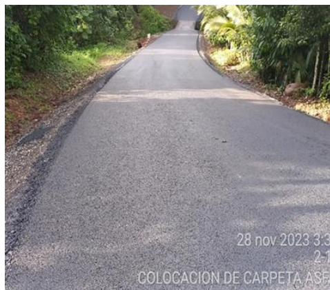
Asfalto en Montelimar, Monterrey
