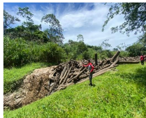
Palizada sector Concepción de La Palmera
