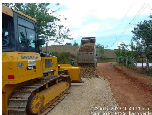
Colocación de material en camino 2-10-1256
