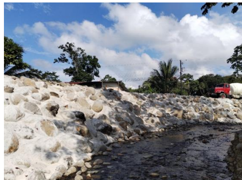
Protección a enrocado río Aguazarquitas
