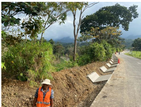
Cunetas para canalización de agua camino 2-10-135
