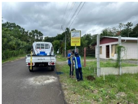
Colocación de rótulo Calle Carvajal
