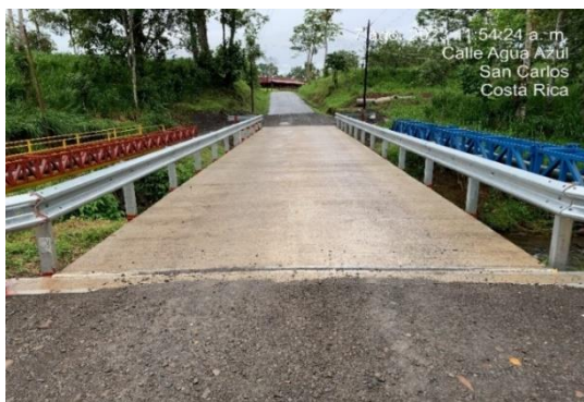
Puente Vehicular, Agua Azul, La Fortuna
