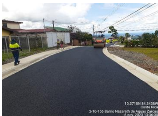
Carpeta asfáltica en Nazaret, Aguas Zarcas
