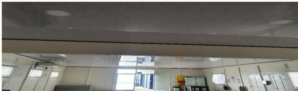
Cambio tablilla de cielorraso
