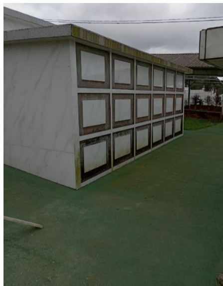
Construcción de nichos
