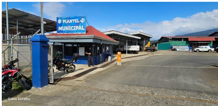
Revisión constante de las instalaciones municipales
