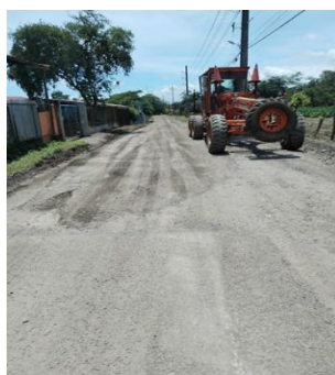
Conformación Tres Esquinas, La Fortuna
