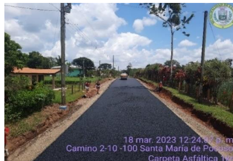
Carpeta Asfáltica, El Estrito, Pocosol Fuente: Municipalidad de San Carlos
