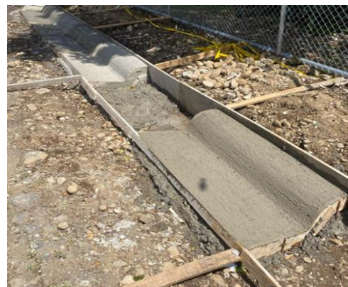
Construcción de aceras, La Leyla
