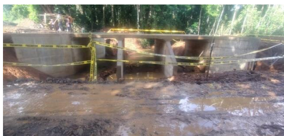
Evacuación Pluvial, El Sahino, Pital
