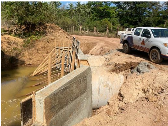
Colocación de material en camino 2-10-249
