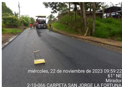
Carpeta Asfáltica, San Jorge, Fortuna Fuente: Municipalidad de San Carlos
