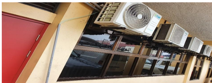
Cambio de Ventanas, Marcos Exteriores
