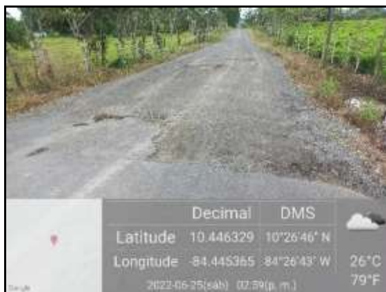
Foto N.º 26: Final de carpeta asfáltica. Luego continua en lastre.
