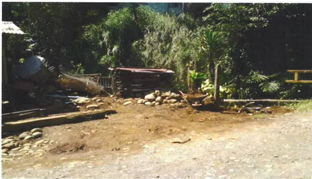
Construcciones cercanas al puente sobre la Quebrada San Pedro, del Barrio Cristo Rey de Ciudad Quesada, 19 de enero de 2011, a las 10:46 a.m.
