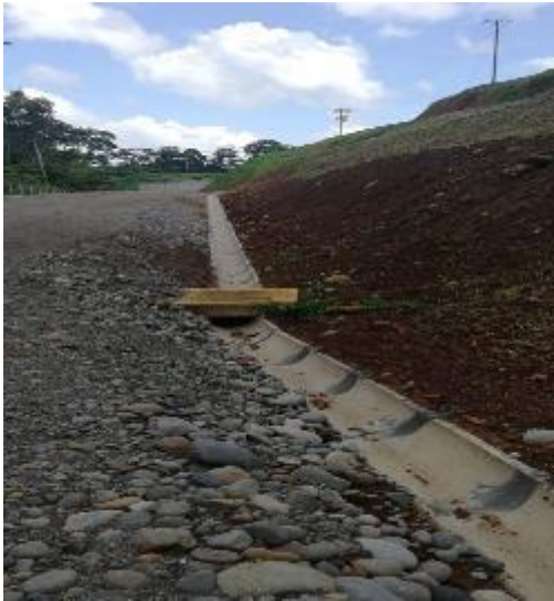
Ilustración 25. Construcción de sistema pluvial en el Relleno Sanitario
