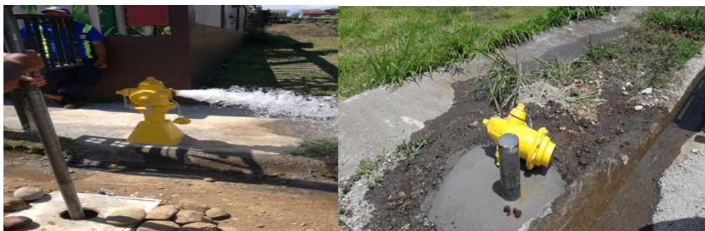
Ilustración 72 Instalación de hidrantes
