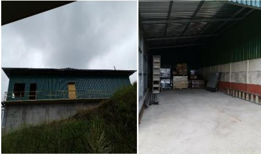
Ilustración 78. Construcción de bodega de Acueductos
