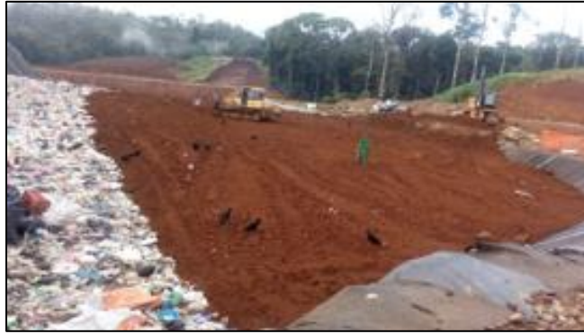
Ilustración 24. Proceso para tapar la basura en trinchera
