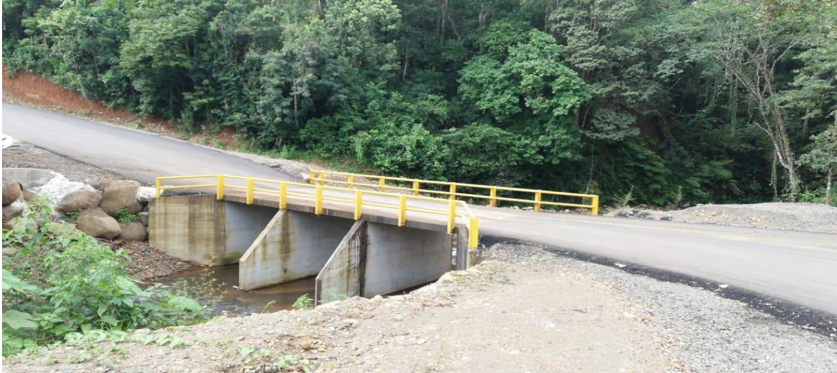
Ilustración 87. Construcción de alcantarilla de cuadro triple para paso
