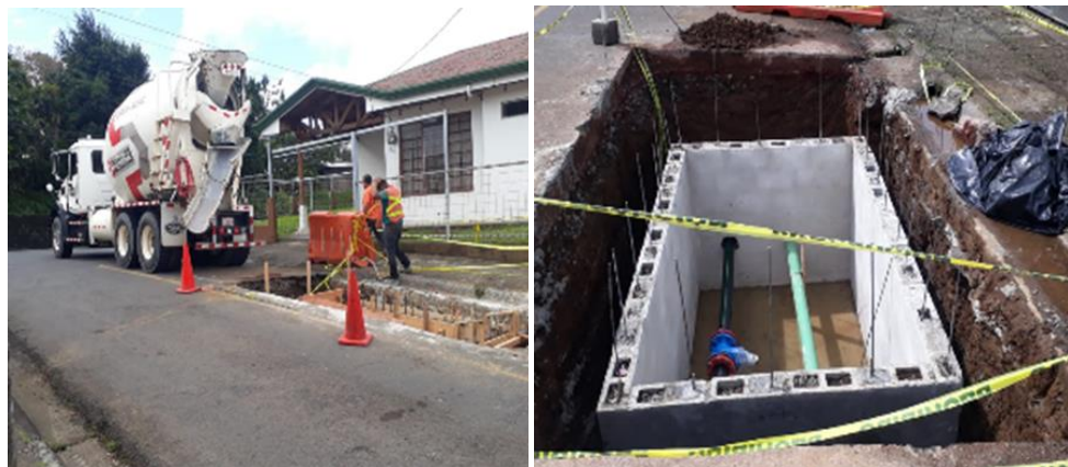
Ilustración 73 Mejoras al Acueducto Municipal
