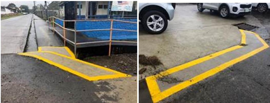
Ilustración 67 Construcción de rampas
