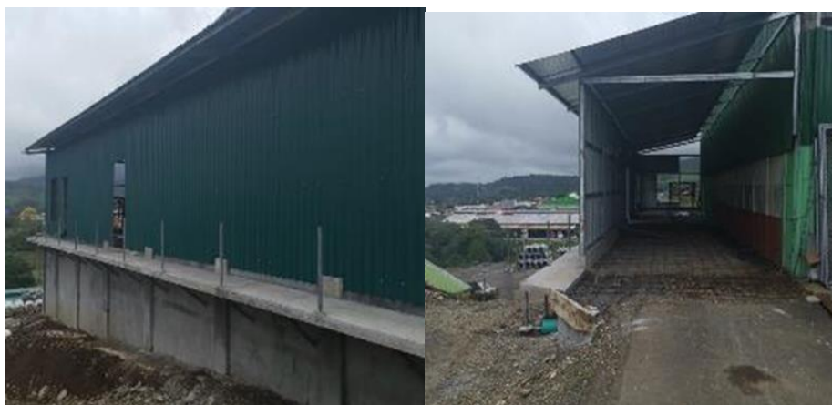
Ilustración 77. Construcción de bodega de suministros
