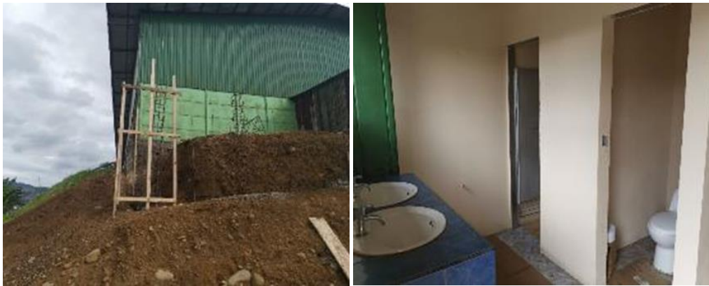
Ilustración 76 Remodelación de sanitarios en el Plantel Municipal
