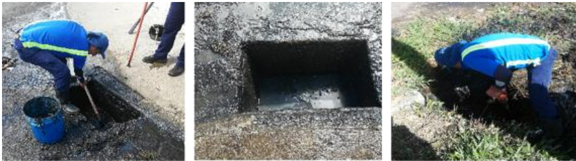
Ilustración 21. Limpieza de cajas de registro, enero-diciembre 2019
