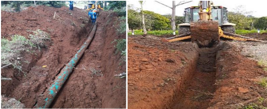
Ilustración 71. Instalación de tubería para línea de distribución Saino-Boca Tapada
