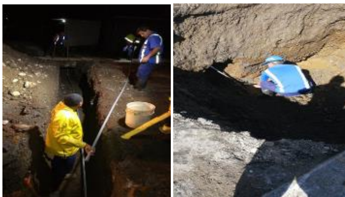
Ilustración 32. Reparación de averías en situaciones de emergencia
