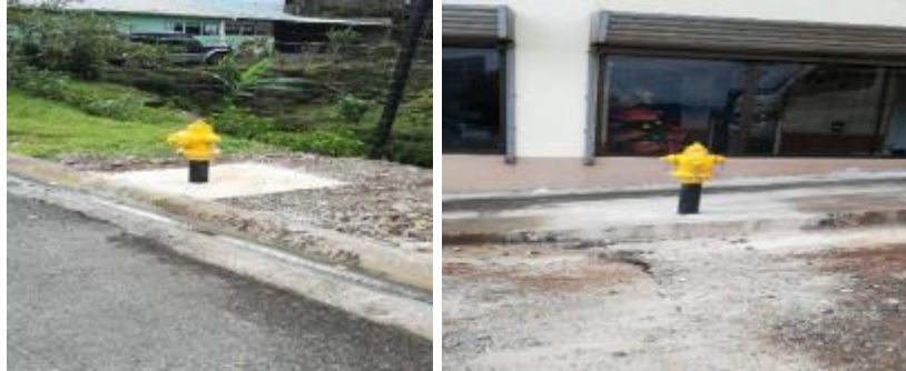
Ilustración 30. Instalación de hidrantes
